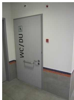
Weg von der Umkleidekabine zum Sanitärraum
